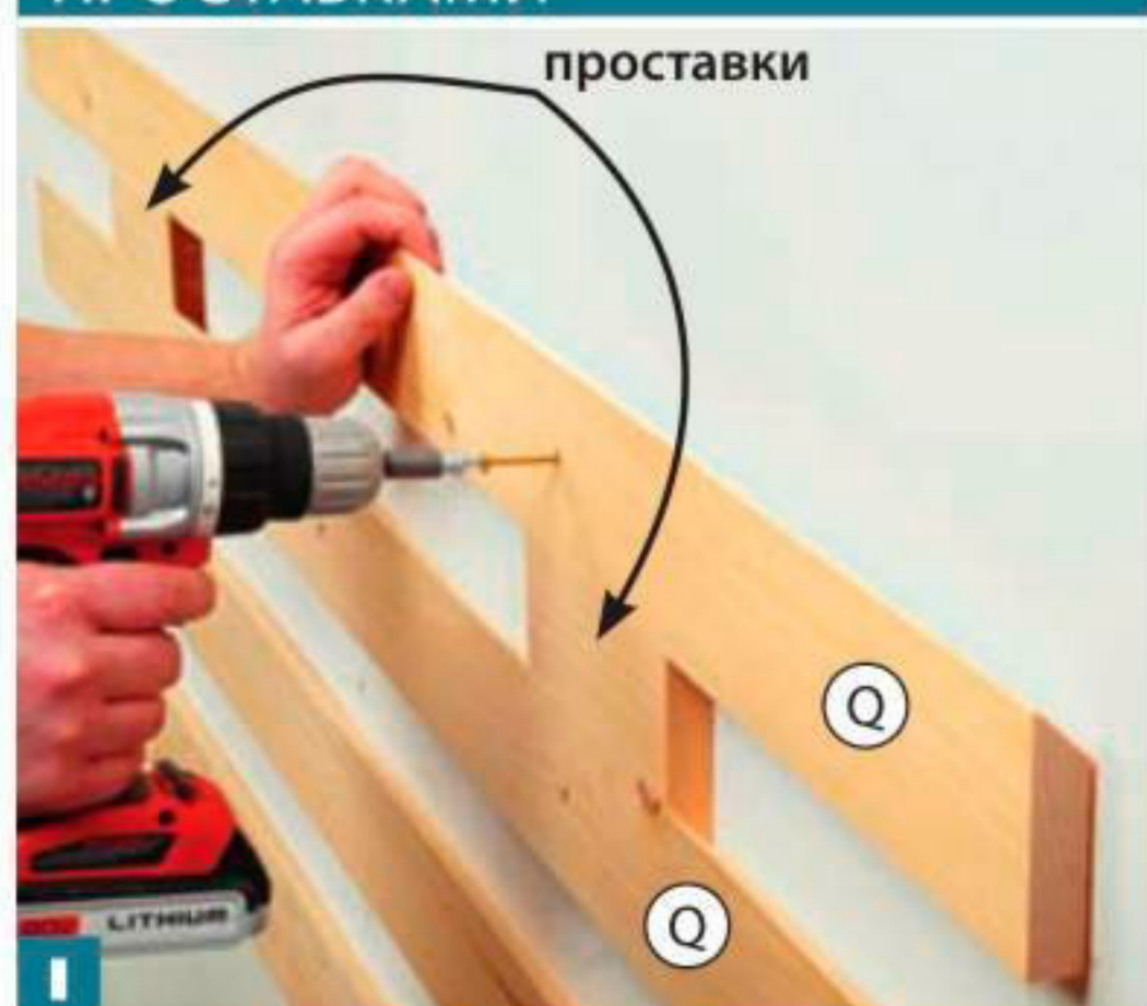
Проставки шириной 83 мм со скосами, сделанные из обрезков, помогут выровнять интервалы между горизонтальными планками (Q), которые крепятся шурупами к стойкам каркаса стены.
