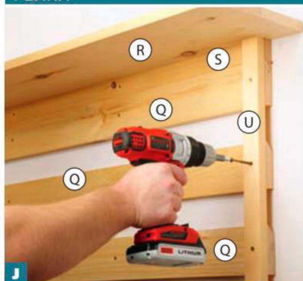
Вверните шурупы длиной 76 мм сквозь вертикальную рейку U и концы горизонтальных планок Q в расположенную за обшивкой стены стойку.
