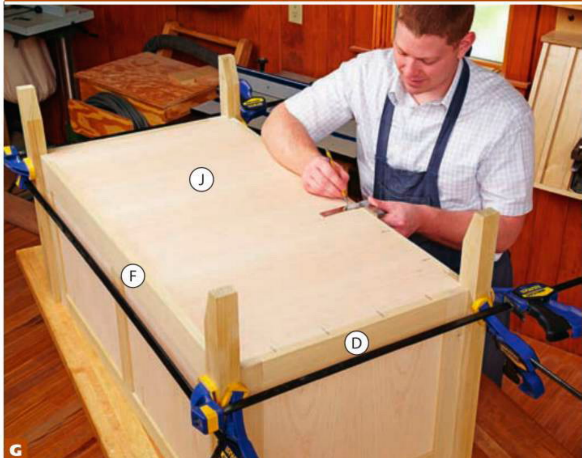
Пользуясь карандашом и угольником, поставьте метки поперек стыков дна J и смежных перекладин через каждые 150 мм.
